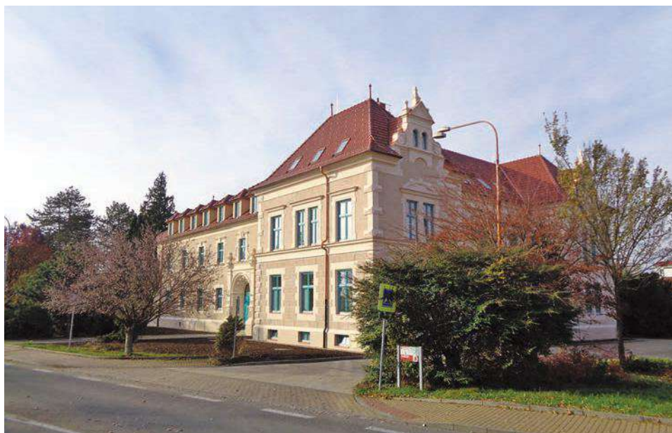
18 Protože zájem posluchačů předčil očekávání, nechal kníže Jan II. z Lichtenštejna postavit novou budovu (1900), nyní (2019) upravenou na děkanát Zahradnické fakulty Mendelovy univerzity. Zdroj: foto Zdeněk Novák (2019).
