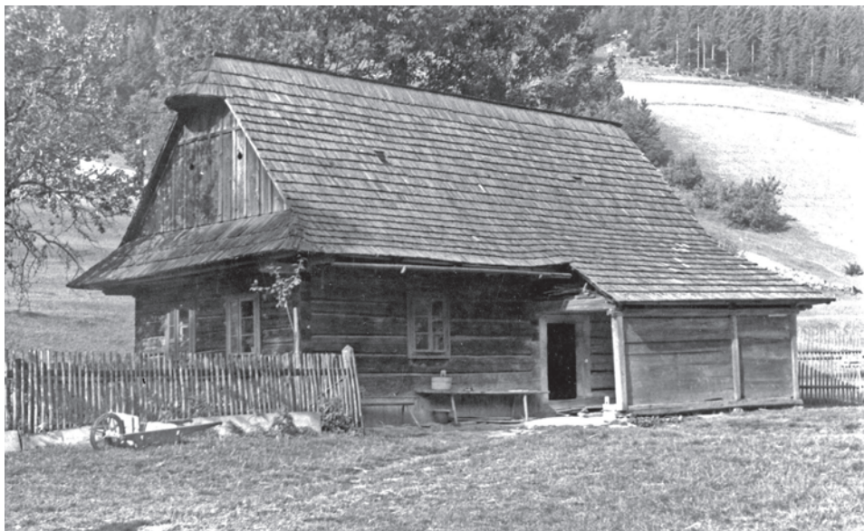
4 Roubený valašský dům se sedlovou střechou krytou šindelem, s tradičním podlomením pod dřevěným štítem, s podsínkem v podélném vstupním průčelí. Datována 1836. Nový Hrozenkov (údolí Bzové). Foto: Antonín Tenzer, 1942. Zdroj: fond ZA ČAVU, HK99742.
