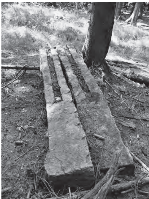
Obora Roštejn (okr. Jihlava), detail zachycující původní žulové sloupky obory s tesanými drážkami pro umístění dřevěných ráhén. Foto K. Vaníček, 2008.
