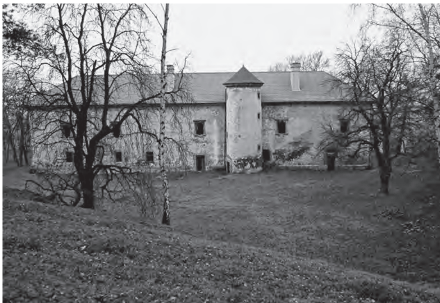
Lovecký zámek Vřísek - Vítkovec (okr. Česká Lípa), stávající stav budovy, pohled od jihovýchodu. Foto D. Tuma, 2006.
