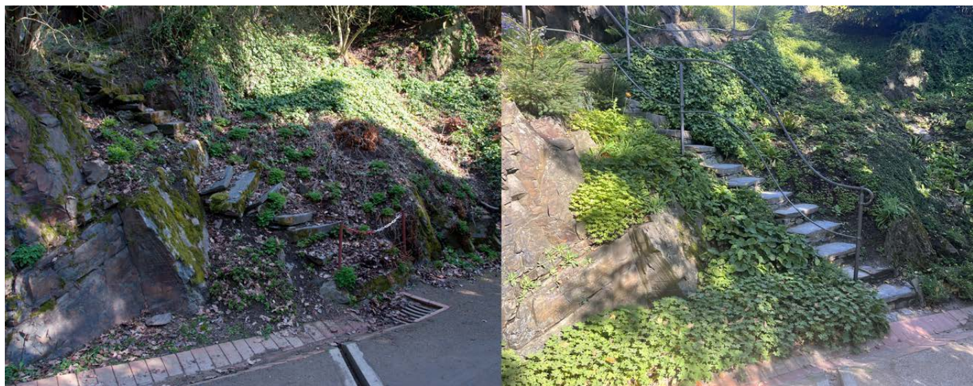
Obr. č. 7: Podzámecké alpinum – obnova kamenných schodů s kovaným zábradlím. Zdroj: archiv ateliéru FLORART, 2014; Jiří Šmída, 2025
