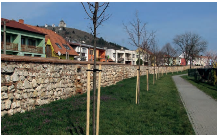
Zachovaná část zdi bažantnice
