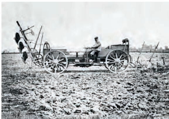
Motorový pluh Snětinův, č.neg. 52988-a11639 Prospekt motorového pluhu, patent V. Snětina, z roku 1912
