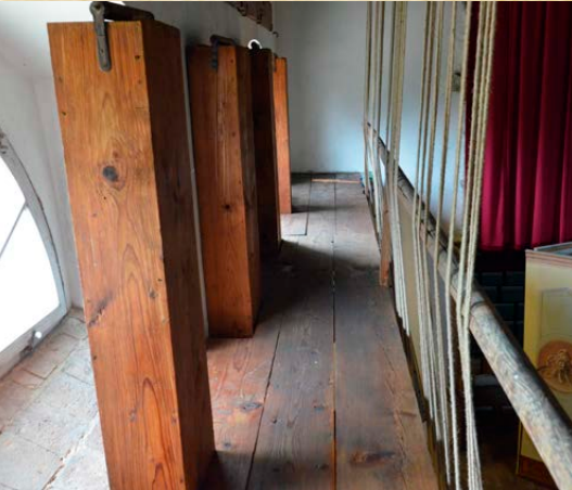
Lávka a 4 dřevěné šachty se závažími
