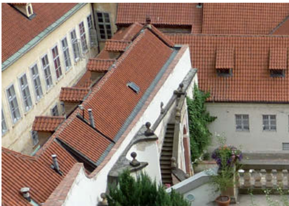
14 Pohled na nefunkční pravé rameno schodiště. Zdroj: foto Zdeněk Novák (16. 8. 2011).
