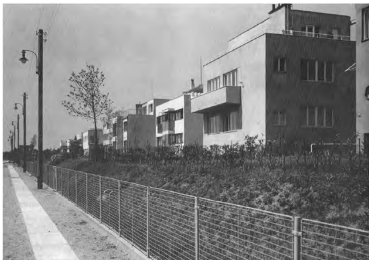
25 Ulice Na Ostrohu s charakteristickým povrchem chodníku kombinujícím mlat a středový pruh velkoformátové betonové dlažby. Zdroj: Anonym, kolem 1932 in: ŠENBERGER, Tomáš – ŠLAPETA, Vladimír – URLICH, Petr, Osada Baba. Plány a modely. Praha 2000, s. 26.
